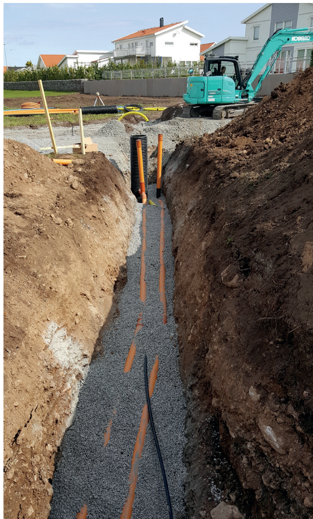
Rörgraven får inte återfyllas innan servisbesiktningen är godkänd.
